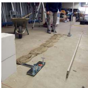
Nivelage des accessoires de pose et mise en place du mortier de base
