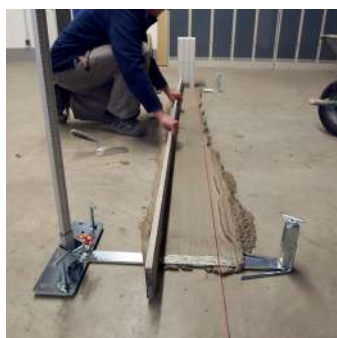
Retrait plan du lit de mortier dans le sens de la longueur et de la largeur
