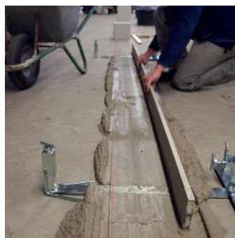
Verlängern des Mörtelbetts durch Versetzen einer Anlegehilfe
