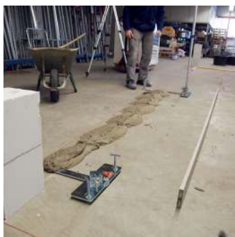
Ausnivellieren der Anlegehilfen und auflegen des Ansetzmörtels
