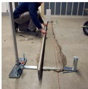
Planes Abziehen des Mörtelbetts in Längs- und Querrichtung
