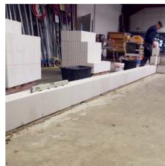
Setzen der Steine ohne großen Aufwand, zügiges Mauern ohne Stoßfugenvermörtelung
