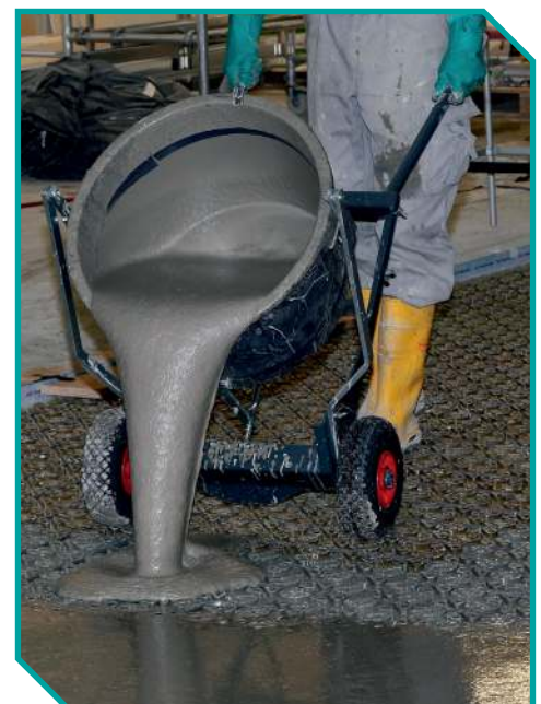
Ausgießen von flüssigen Mischmaterialien
